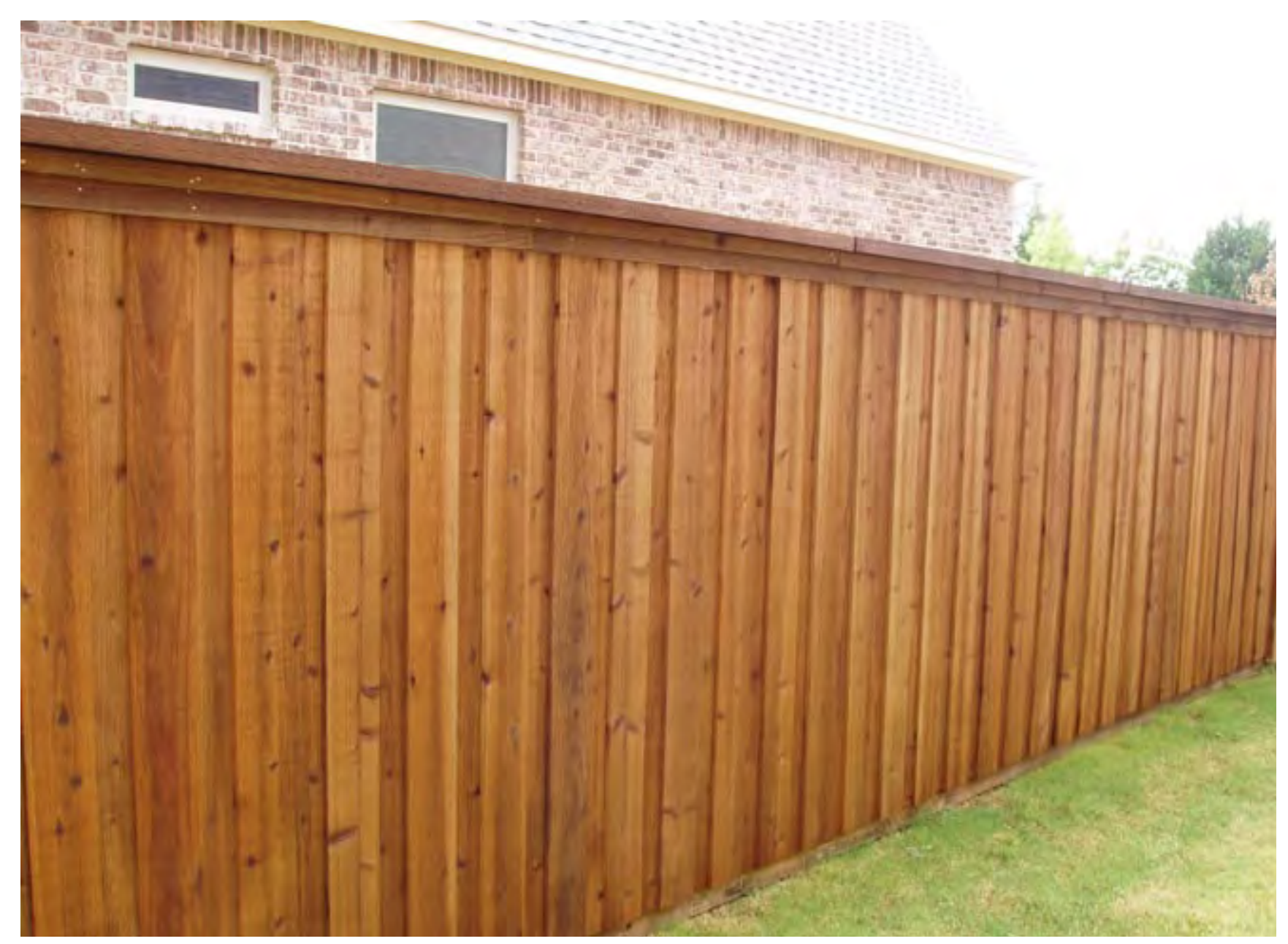
WESTERN EDGE FENCE
